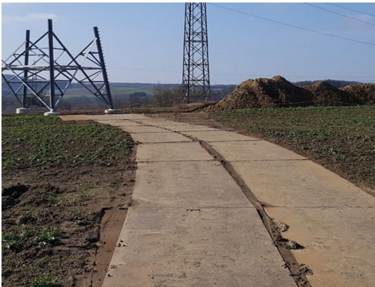
Abbildung 24: Temporäre Zuwegung über Fahrbohlen wie hier mit Stahlplatten
