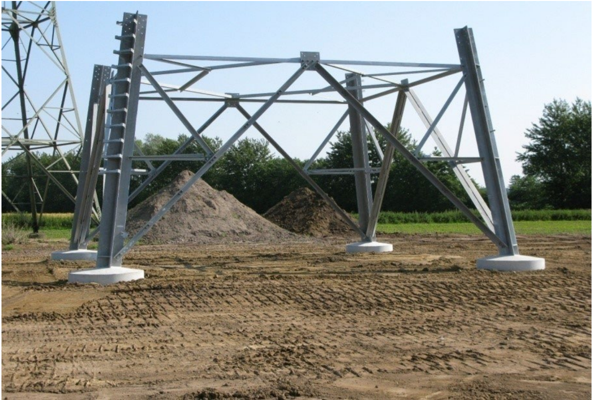
Abbildung 29: Montierter Mastfuß mit bereits wiederhergestellter Umgebungsfläche
