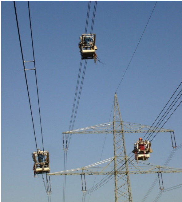
Abbildung 33: Montage der Feldbündelabstandshalter mit Fahrwagen
