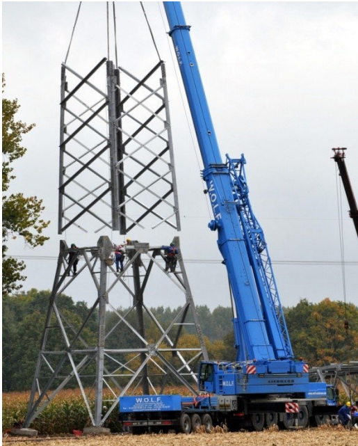
Abbildung 30: Mastmontage (Stocken)
