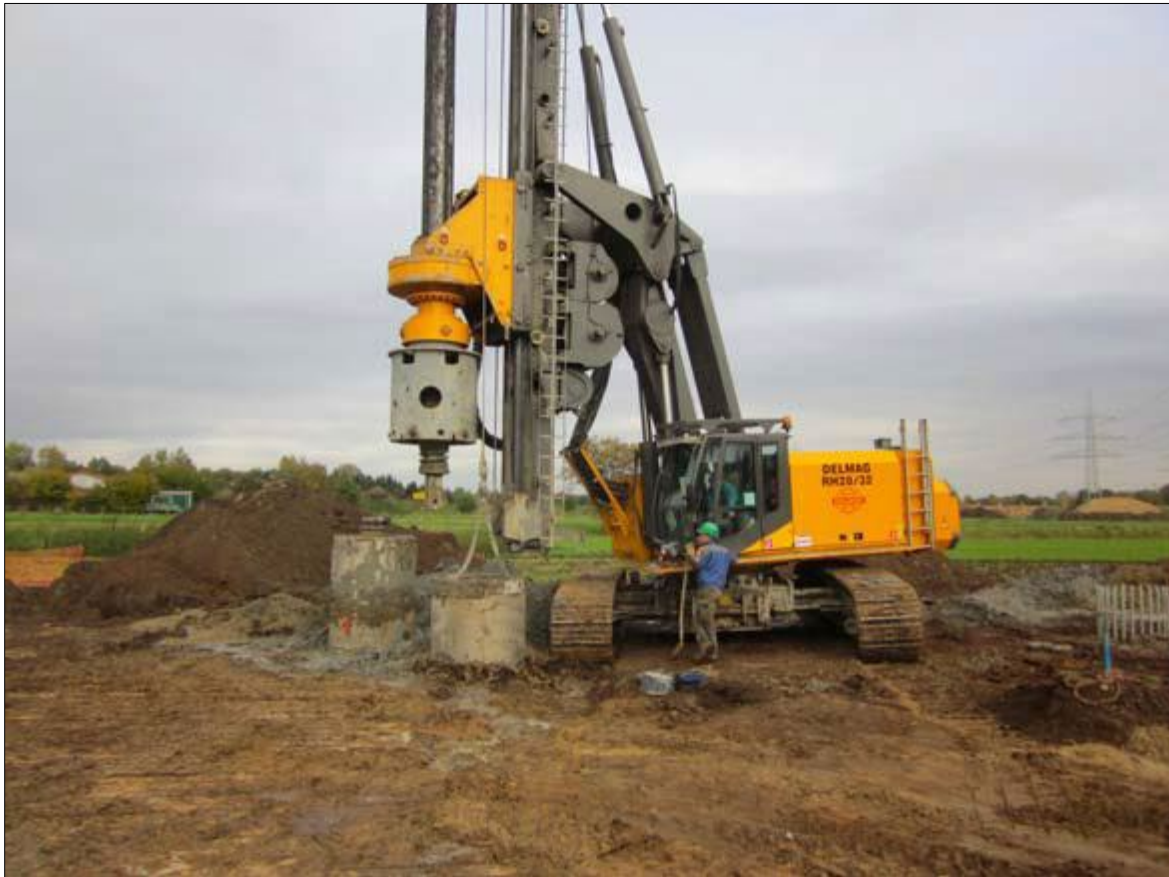
Abbildung 20: Bohrung für einen Bohrpfahl
