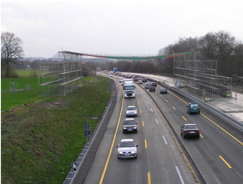
Abbildung 34: Stahlrohrkonstruktion mit Netz zum Schutz über einer Autobahn
