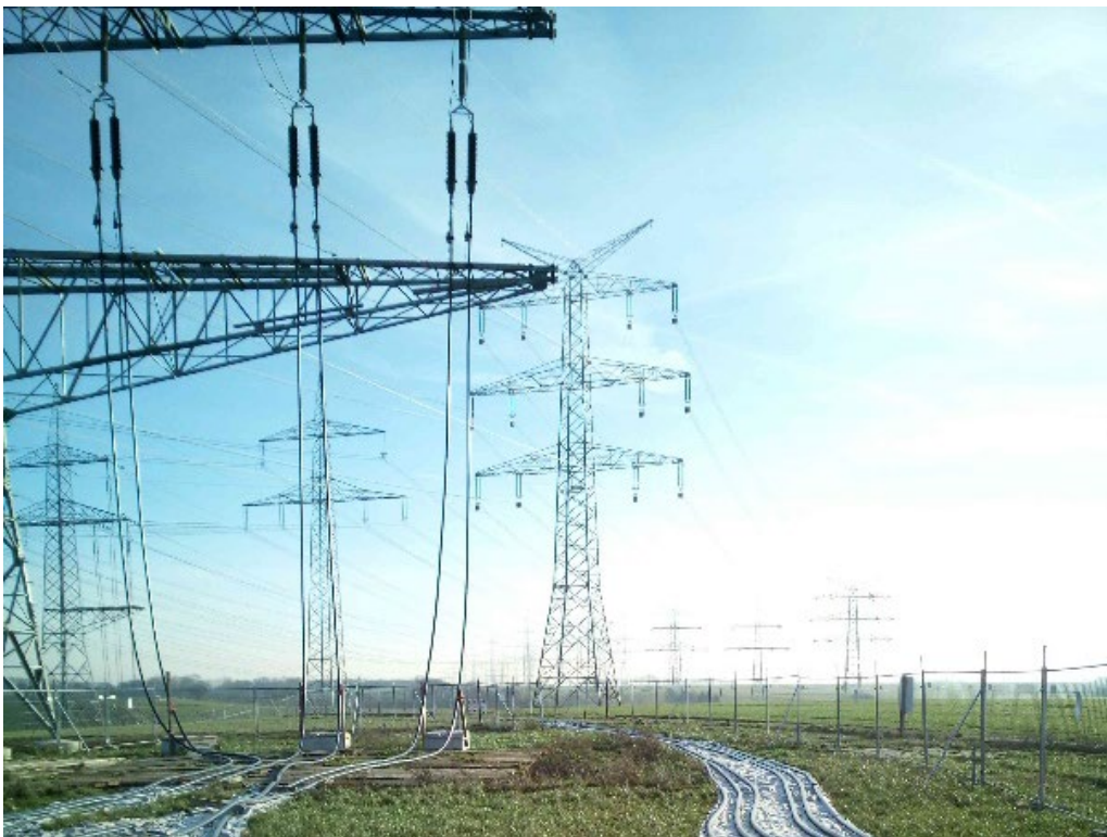
Abbildung 38: Anbindung BEK an Freileitung
