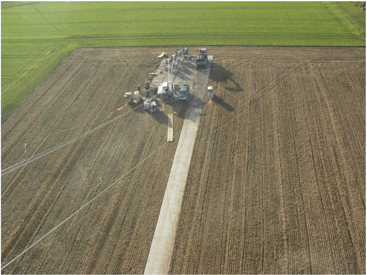
Abbildung 32: Windenplatz eines 4er-Bündel-Seilzuges
