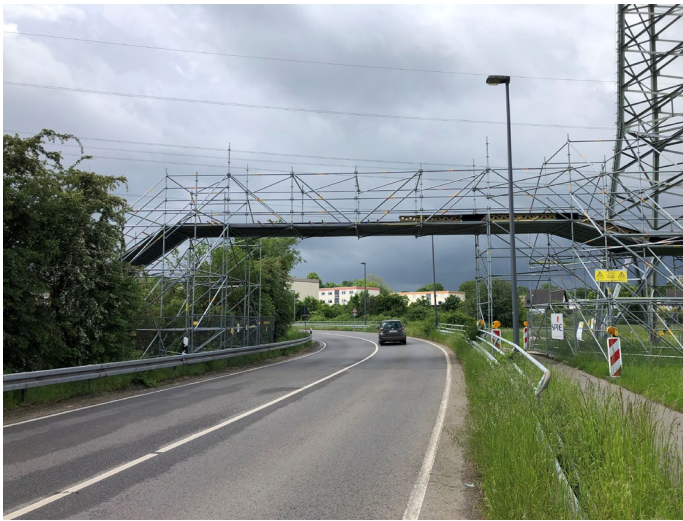
Abbildung 36: Kabelbrücke BEK über Straße
