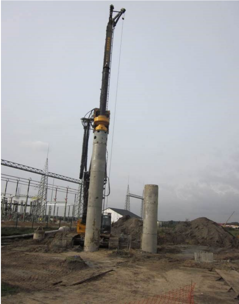
Abbildung 28: Bohrung für einen Bohrpfahl
